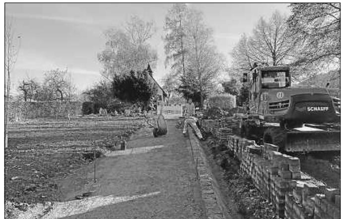
Der Unterbau wurde auf Niveau gebracht, die vorhandene Einfassung und der alte Pflasterbelag wieder verwendet und neu verlegt.
