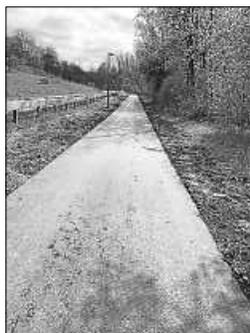
Aufgrund von Fahrbahnschäden und Setzungen wurden durch die Firma Zehnder Straßenbau aus Rudersberg vom 11.04.2023 bis 20.04.2023 weitere Teilabschnitte des Geh- und Radwegs zwischen Oberweissach und Aichholzhof saniert. Der erste Abschnitt „Radschulweg zwischen Oberweissach und Bruch“ wurde bereits im Oktober 2022 saniert. Die Arbeiten am 2. Abschnitt umfassten eine Länge von 140 m und der 3. Abschnitt eine Länge von 130 m.
