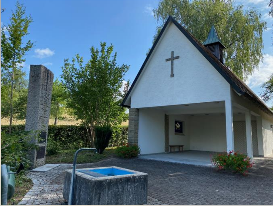
Aussegnungshalle Bruch mit Vorplatz
