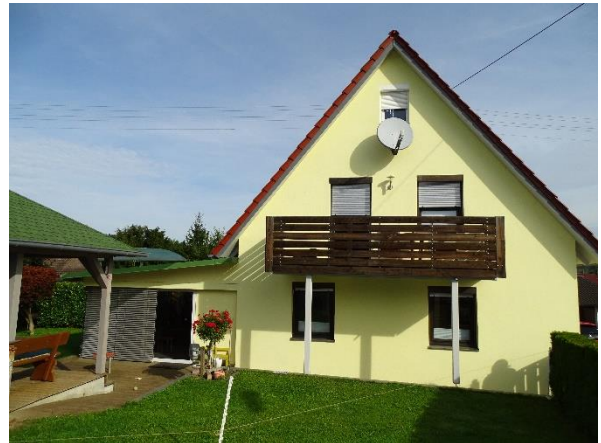
Abb. 4: Blick auf das Einfamilienhaus Gassenäcker 6, Südseite
