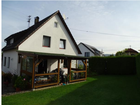
Abb. 7: Gebäude In den Gassenäcker 4
