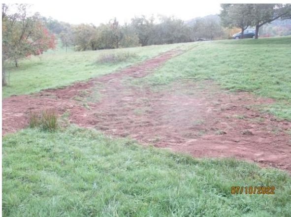
Abb. 9: Bodenmodellierung zur Schaffung eines Kleingewässers
