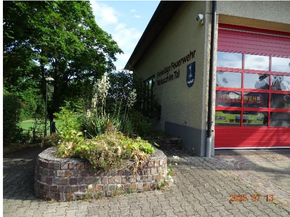
Abb. 20: Pflanztrog auf Westseite des Feuerwehrgebäudes
