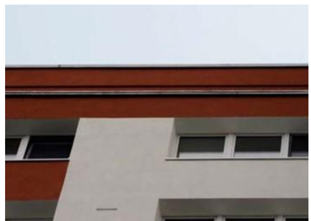
Abb. 36: Doppelwandige Attikaverkleidung 17
