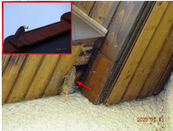
Abb. 12: Nest eines Hausrotschwanzes (roter Pfeil) auf Nordwestseite des Feuerwehrgebäudes mit Bild des fütternden Altvogels
