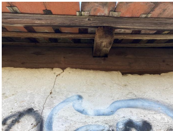
Abb. 7: Walmdach der Alten Kelter, Dachtrauf
